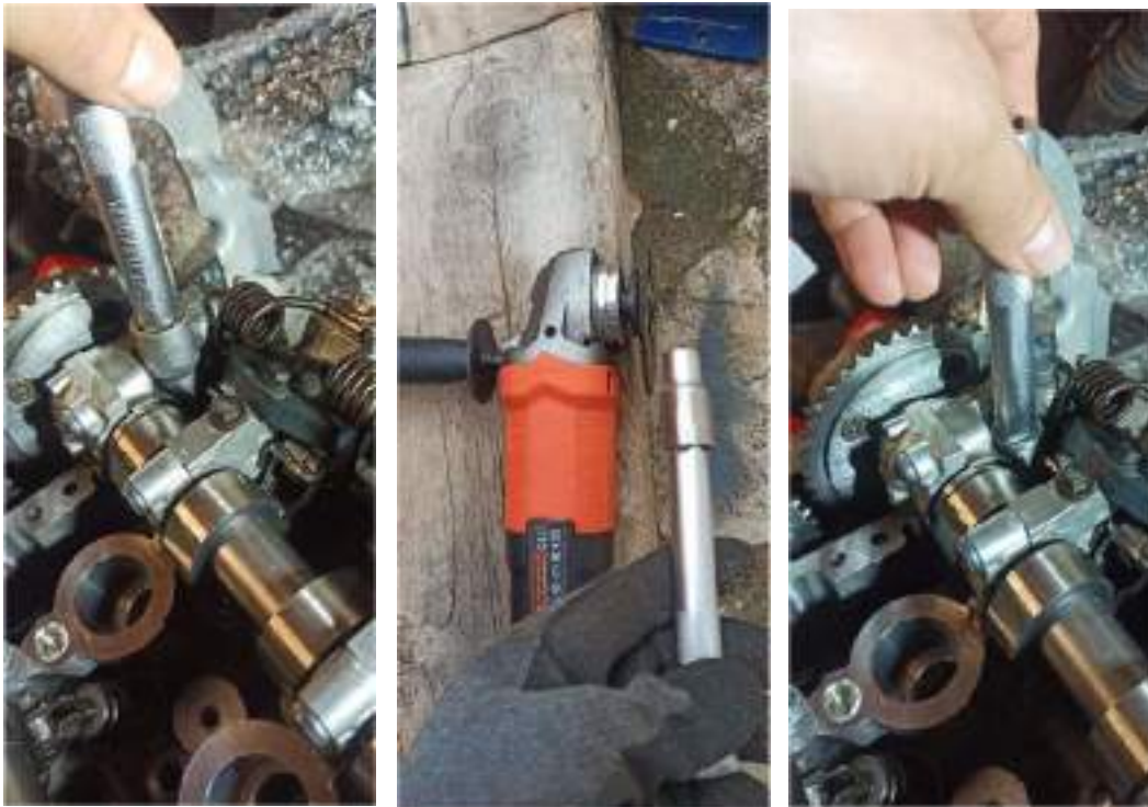
Ilustración 74: La llave 12 torx que no entraba (izquierda); su rebaje con radial (centro); y ya entrando (derecha).
